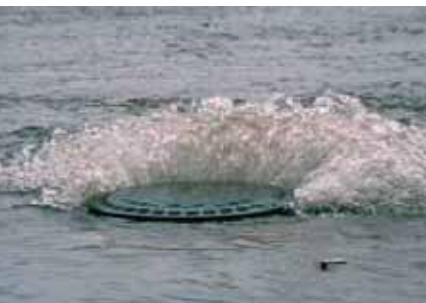
Durch Starkregen überlastete Kanalisation (Quelle: itwh)
