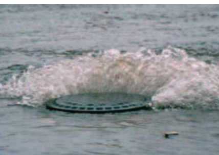
Durch Starkregen überlastete Kanalisation (Quelle: itwh)
